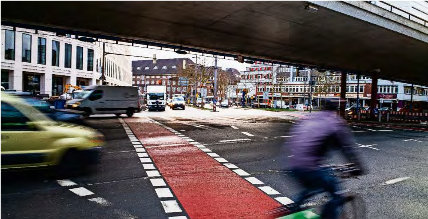
Verbesserungsbedürftig: Der Zustand des Straßennetzes insbesondere in der Stadt Bremen ärgert vor allem (aber nicht nur) die Verkehrs- und Logistikbranche. Fotos: Heumer
