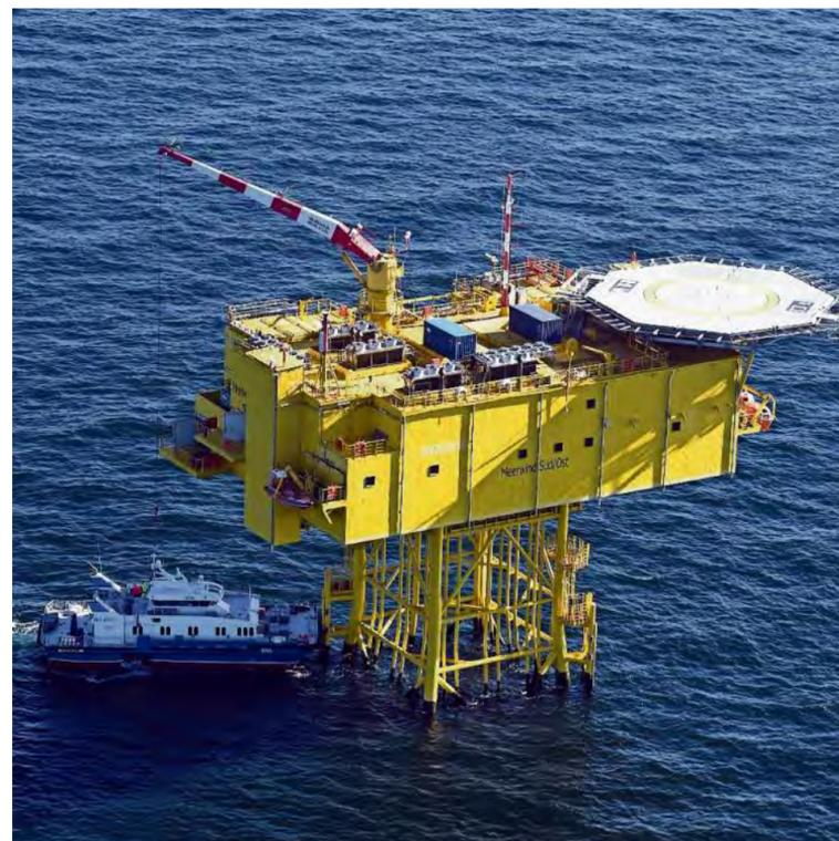
Schaltzentrale auf hoher See: In der Umspannstation nördlich von Helgoland wird der auf See erzeugte Strom ins Kabelnetz eingespeist.
