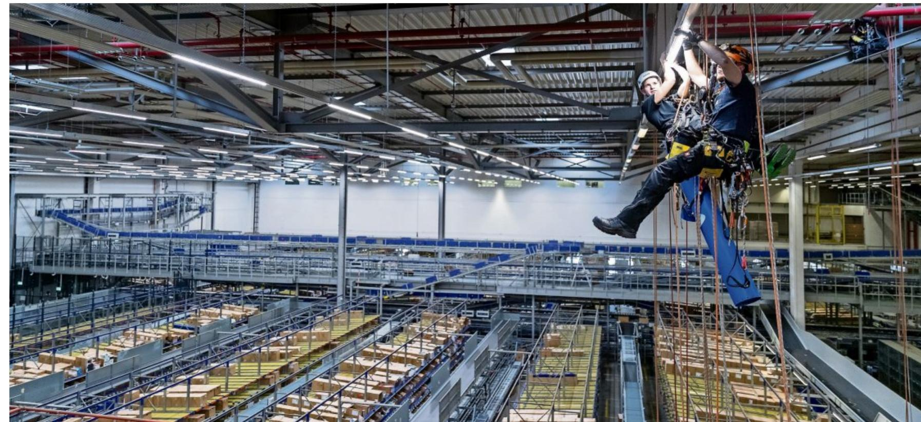
Robin Bender (hinten) und Eike Precht-Rümenapf ersetzen in der Kombihalle am Tchibo-Hochregallager in Bremen an der 15 Meter hohen Hallendecke Leuchtstoffröhren gegen LED-Lichtbänder.
