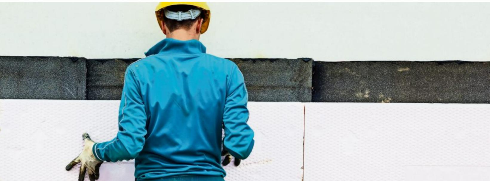
Ein Bauarbeiter montiert Dämmplatten an einer Hauswand. Neben der Dämmung beeinflussen moderne Anlagentechnik und die Nutzung von Fernwärme die Klimabilanz. Foto: Wodicka/Colourbox
