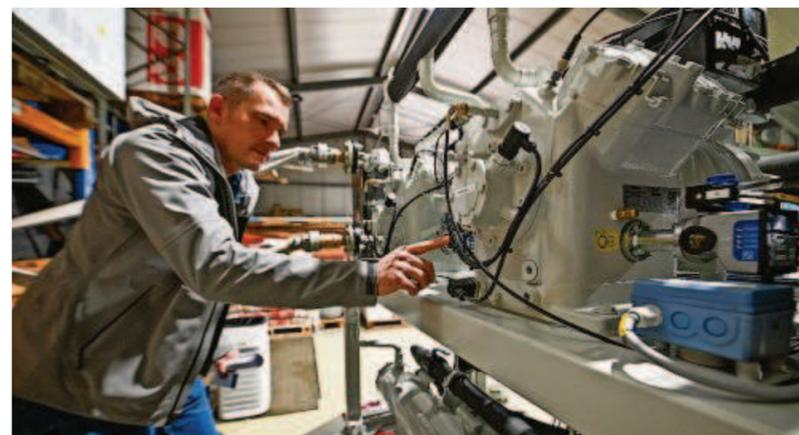
„Uthörn“-Chief, Schiffsingenieur Eric Mühle, begutachtet die erste Wasser-Wasser-Wärmepumpe, die in einem Schiff eingebaut wird.
