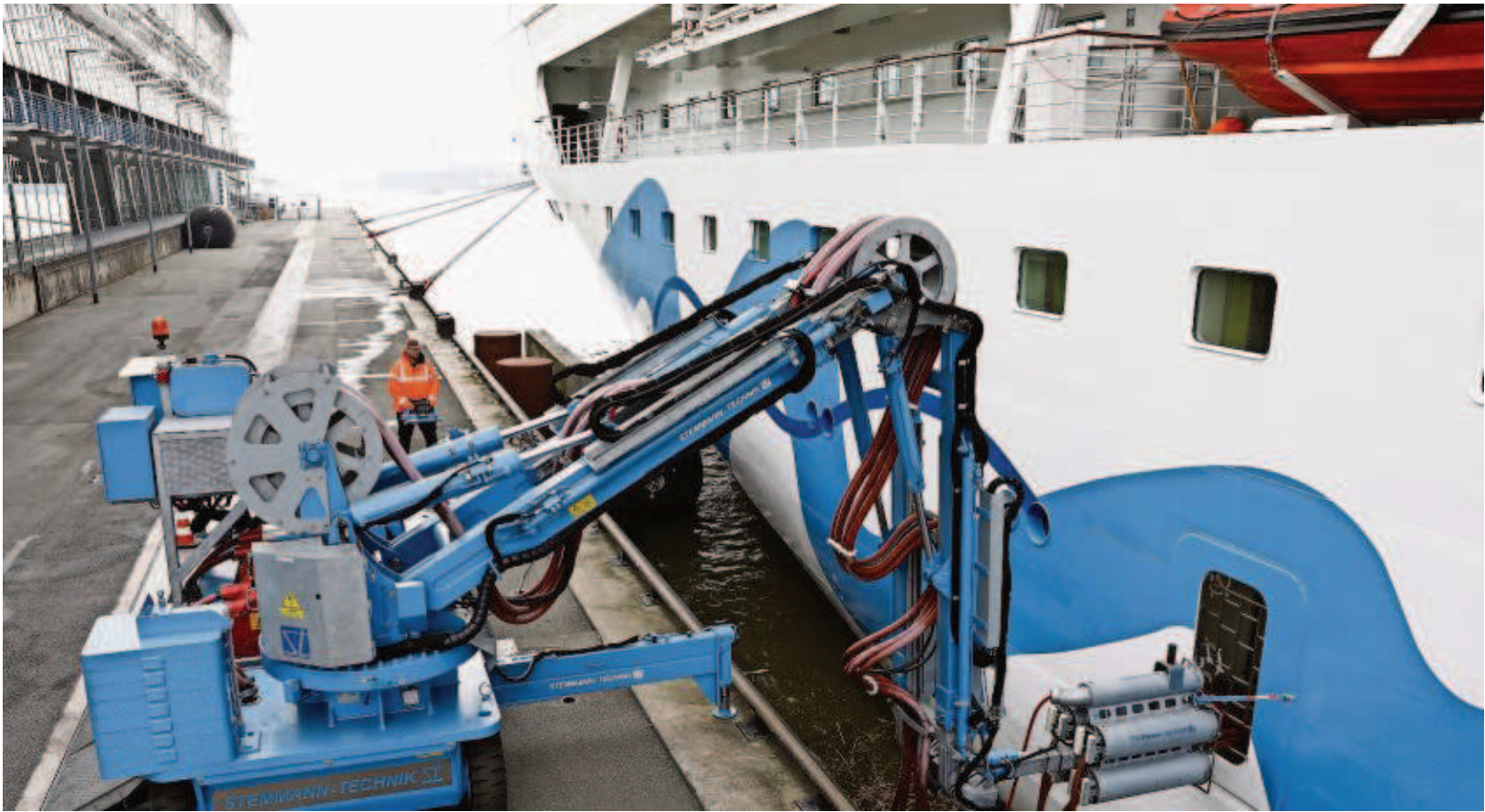
In Hamburg-Altona gibt es schon eine Stromversorgung für Kreuzfahrtschiffe. Auch an der Bremerhavener Columbuskaje soll jetzt eine solche Anlage gebaut werden. Insgesamt werden im gesamten Hafengebiet sieben Landstrom-Anlagen entstehen. Foto: Charisius/dpa
