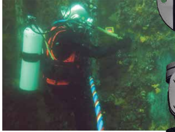
Wenn Spundwände im Hafenbereich überprüft werden müssen, rücken Taucher an. Die Daten der Prüf- und Messgeräte werden von PBVoss ausgewertet.
