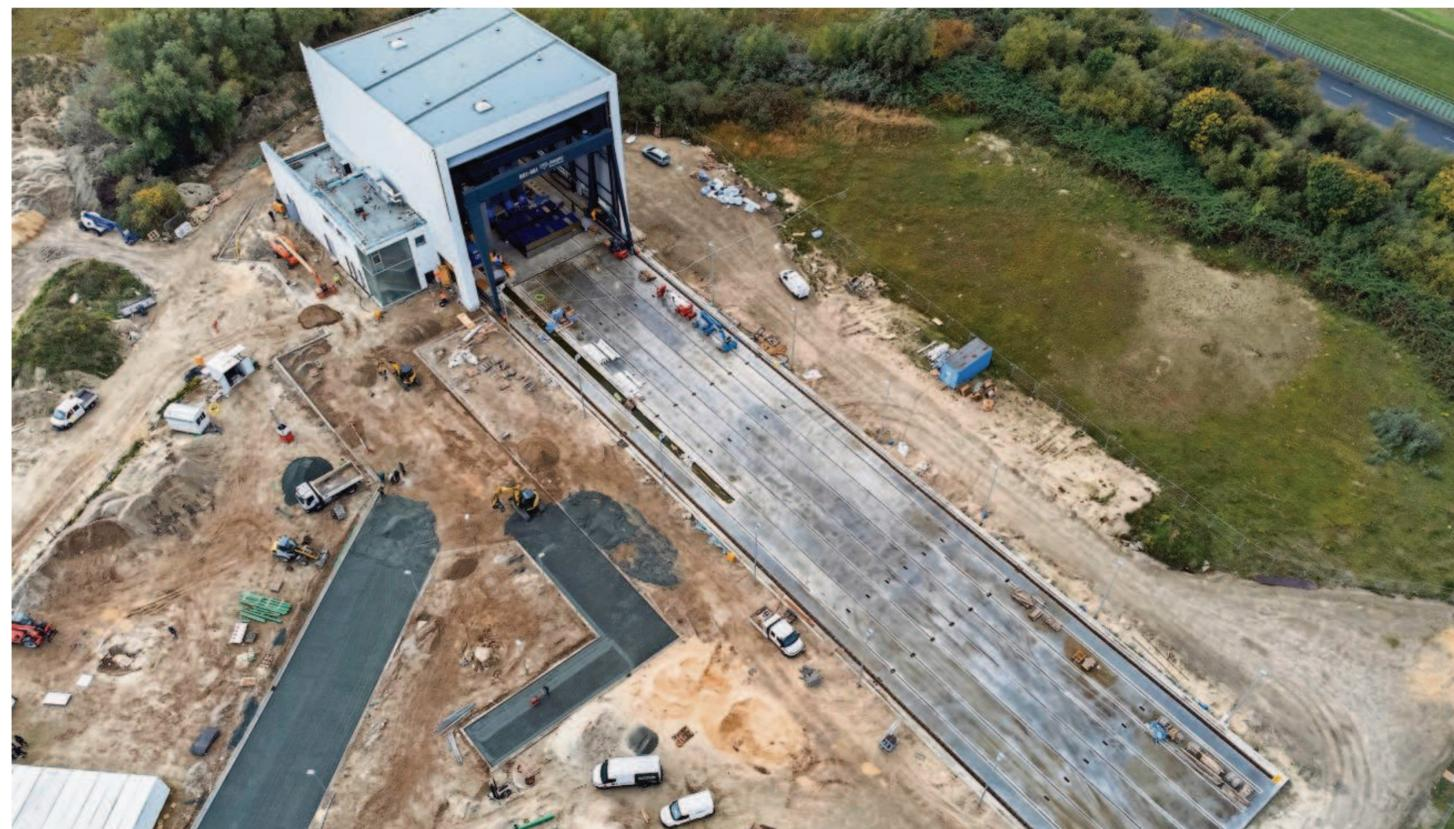
Ein Riesenteststand aus der Vogelperspektive: Am Fraunhofer-Institut für Windenergiesysteme IWES in Bremerhaven entsteht derzeit der größte Rotorblatt-Prüfstand der Welt. Hier können künftig Rotorblätter mit einer Länge von mehr als 120 Metern auf ihre Stabilität im Dauereinsatz geprüft werden. Foto: Sarbach/WFB
