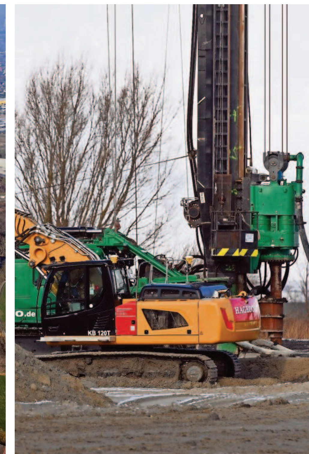
Die Bauarbeiten für den Logistik-Campus Bremerhaven haben begonnen. Foto: Scheer
