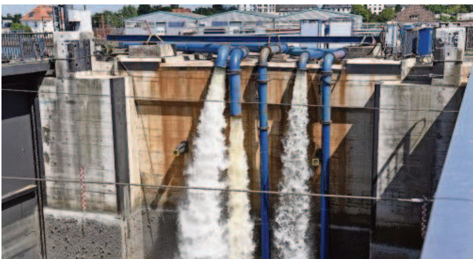
Wasser marsch: Die Dockgrube der Kaiserschleuse wird nach den Reparaturarbeiten wieder geflutet.
