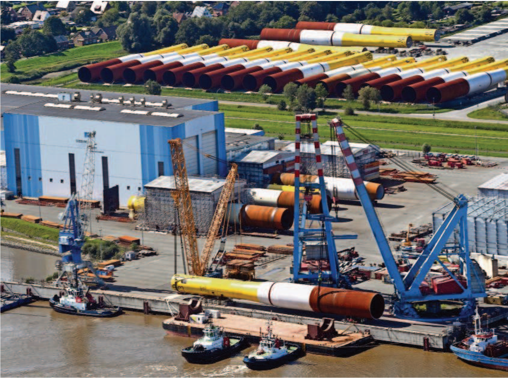
Monopiles werden bei Steelwind in Nordenham-Blexen verladen. Foto: Scheer
