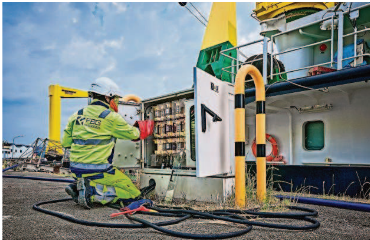
Ein FBG-Mitarbeiter bei der Installation eines Landstromanschlusses. Foto: Langer
