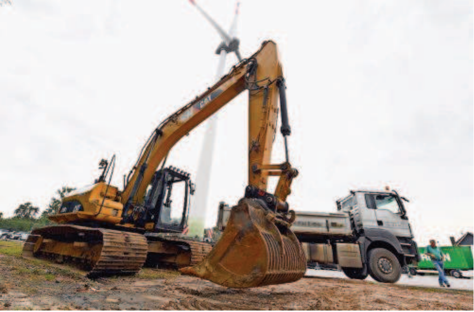
Hier entsteht eine Wasserstoff-Erzeugungsanlage, die noch in diesem Jahr grünen Wasserstoff für die Wasserstoff-Tankstelle „Zur Hexenbrücke“ produzieren soll. Foto: Scheer
