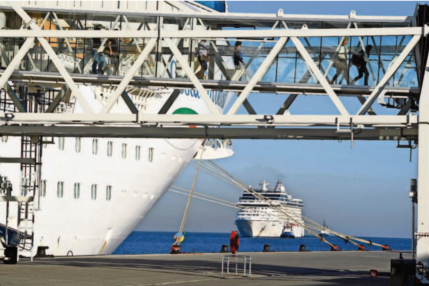
Fahrgäste verlassen ein Kreuzfahrtschiff am Columbusbahnhof über eine der neuen Passagierbrücken, die vor Kurzem installiert wurden. Foto: Scheer
