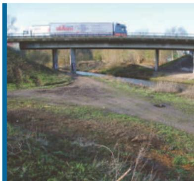
Blick nach Süden auf die marode B73-Brücke in Buxtehude: Das Baufeld ist geräumt. Im Herbst wird an dieser Stelle die Baustellen-Umfahrung mit der Behelfsbrücke errichtet.
