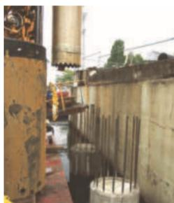
Das Bohrgerät wird neben den fertigen Pfählen neu positioniert.
