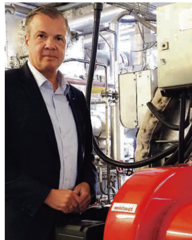
Arnold G. Mergell steht vor dem neuen roten Zweistoffbrenner – für den ein Verfahren nach dem Bundesimmissionschutzgesetz durchgeführt werden musste. Das Unternehmen kann nun sowohl mit Gas als auch mit Öl die hohen Temperaturen für die Produktionsprozesse erzeugen. Die Zweistoff-Lösung sichert den Betrieb für den Fall ab, dass das Gas ausbleibt. Die zweite Anlage im Hintergrund soll ebenfalls umgerüstet werden. Foto: Wolfgang Becker
