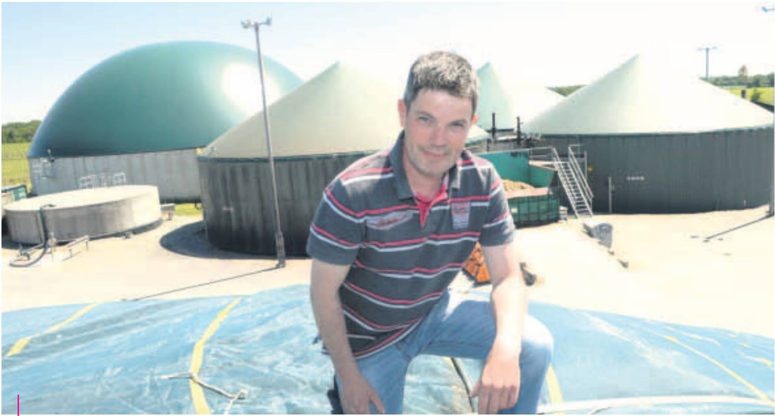
Landwirt Andreas Meybohm setzt seit 2010 auf Energieerzeugung. Im Hintergrund: die Biogasanlage in Schwinge.
