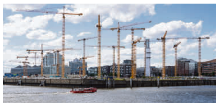
In der Hamburger HafenCity drehen sich seit zwei Jahrzehnten die Kräne – wie hier beim Überseequartier. Die städtische Betreiber-Gesellschaft sieht hier auch ein Versuchsfeld für Zukunftstechnologien, die anderen Stadtteilen zugutekommen werden.
