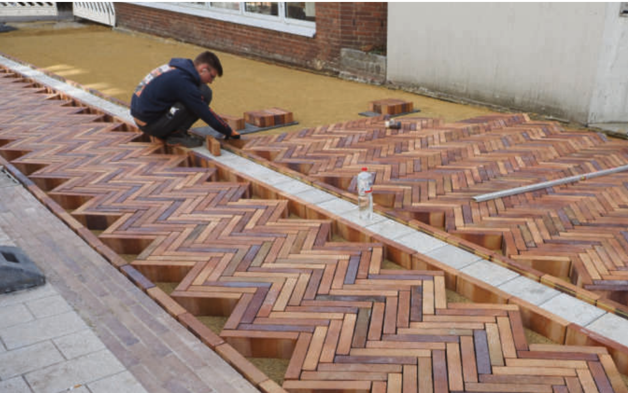
Aufwendige Arbeit: Die hochkant verlegten Pflastersteine, hier bei den Arbeiten in der Hölertwiete, sorgen für eine edle Optik, aber auch für mehr Stabilität. Rechts: Fischgrätenmuster auf dem Harburger Sand – 4,2 Millionen Euro wurden in die Sanierung der Marktfläche und der angrenzenden Flächen wie Schillerplatz und Hölertwiete investiert.
