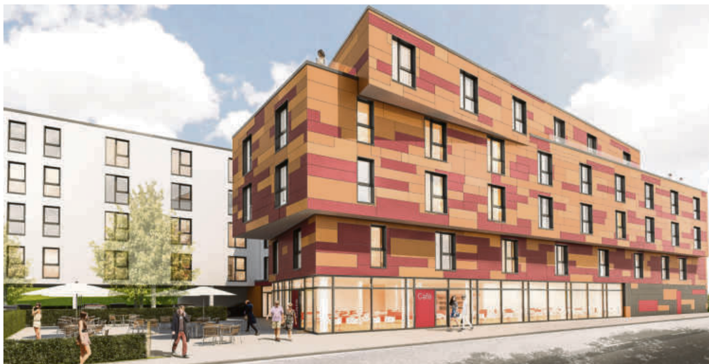
So soll es aussehen: Das Havenhostel Stade wird derzeit nach einem Entwurf von HEP Architekten aus Buxtehude für die Grotelüschen & Weber AG gebaut.
