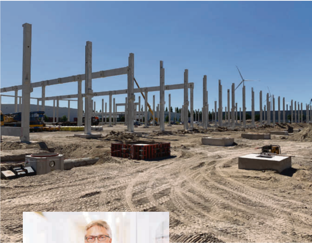
Ein typischer Anblick: So sieht es aus, wenn die Fertigteile aus Stahlbeton aufgestellt sind. Sie bilden das Skelett beispielsweise einer neuen Halle.
