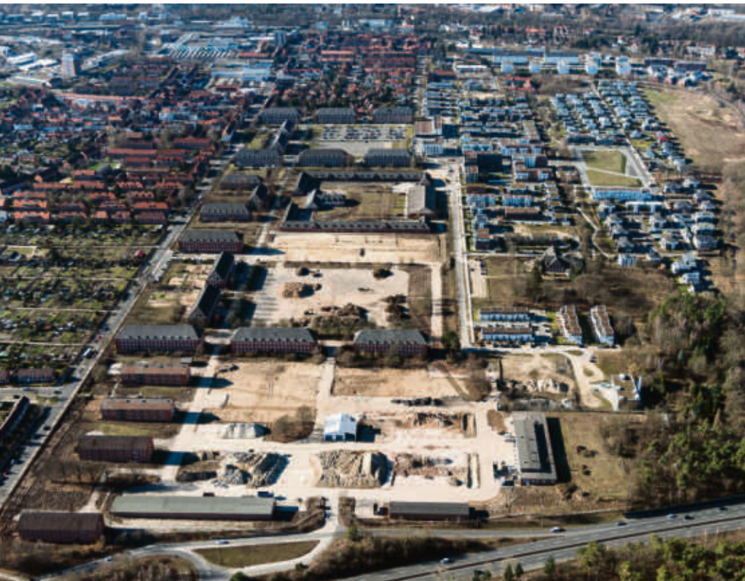
Diese Luftaufnahme zeigt im Vordergrund die mittlerweile fast erschlossene Fläche für das Hanseviertel III in Lüneburg. Im Hintergrund sind die Abschnitte I und II zu erkennen.
