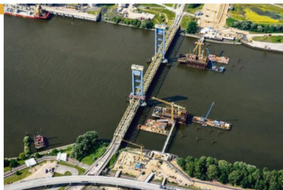
Aus der Luft: So sind die beiden Baugruben für die Stropfweiler in der Süderelbe positioniert. Sie stehen 108 Meter weit auseinander.
