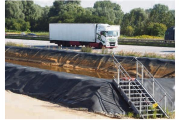
Entlang der A7 sind zwei Auffangbecken für das Wasser aus dem Torf angelegt worden. Eines dient zur Klärung, das andere als Pufferspeicher (Foto). Das saubere Wasser wird dosiert in die Neuländer Wettern geleitet und landet schließlich in der Elbe.
