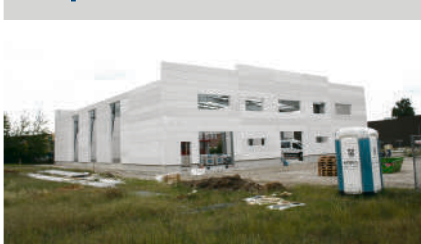
Noch im Bau: Die Stahlkonstruktion mit Porenbetonwänden entsteht zurzeit in Hannover.
