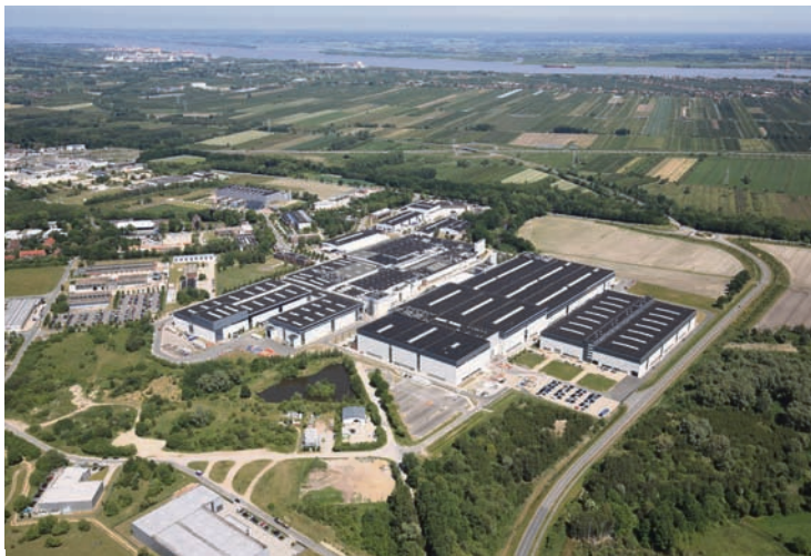
Das Airbus-Werk in Stade dominiert den Stadtteil Ottenbeck, der als CFK-Standort Weltweit impliziert weit über Stades Grenzen hinaus wahrgenommen wird. Das Werk hat zwar nicht annähernd die Dimensionen von Airbus in Finkenwerder, ist aber ebenfalls wie eine Stadt in der Stadt zu sehen.
