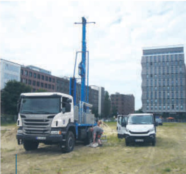
Auf der ehemaligen Beachclub-Fläche am Veritaskai ist ein Bohrgerät zur Untergrundanalyse in Stellung gebracht worden. Hier soll das Hotel gebaut werden.
