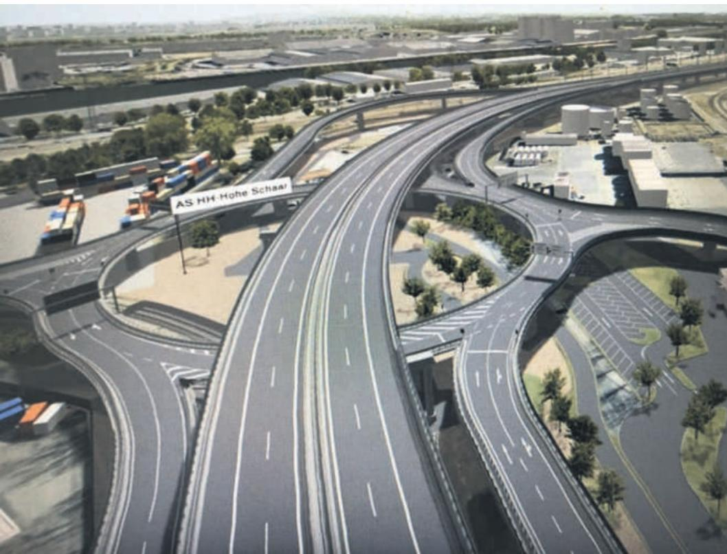
Diese Ansicht auf dem Laptop zeigt den geplanten Kreisverkehr Hohe Schaar – eine bundesweit einmalige Konstruktion in drei Ebenen.
