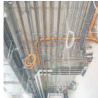
Technik satt: An den Decken verlaufen Leitungen, Lüftungsschächte, Rohre und alles, was zum Betrieb einer Klinik notwendig ist – zum Beispiel Sauerstoffleitungen.
