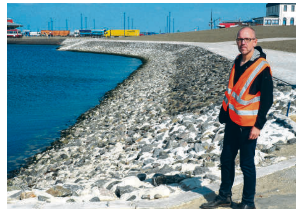
So geht Deichverstärkung heute: Das Foto zeigt Prof. Dr. Peter Fröhle vor einem „verklammerten Deckwerk“ und dem nach oben anschließenden „Treibselabfuhrweg mit Wellenüberschlagsicherung“ – aufgenommen in Tagebüll an der Nordsee.
