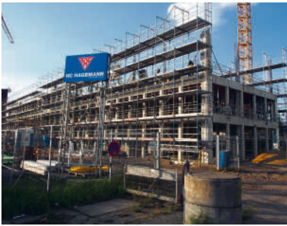
Momentaufnahme vom 19. September 2018: Der erste Eckpfeiler des zweiten Obergeschosses ist gesetzt. Im April/Mai 2019 sollen im Gebäude HIP one die ersten Mieter einziehen. Foto: Wolfgang Becker
