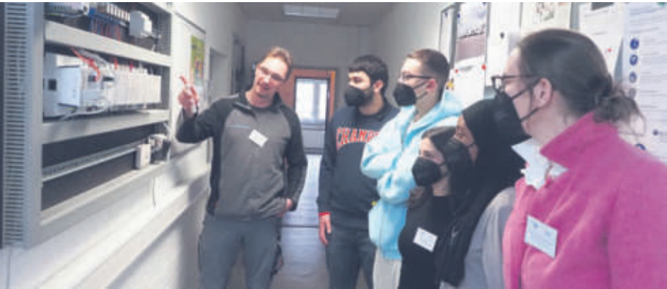
Hier wird's kompliziert: Steffen Koch, Fachmann für Regelungs- und Elektrotechnik, erläutert die Gebäudesteuerung bei Hartmann. Rechts: Lehrerin Konstanze Dammann.
