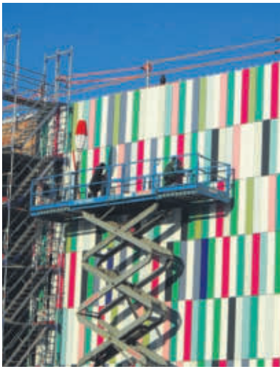
Hier wird Hand an die Fassade gelegt. Sie besteht aus 14 850 vertikalen farbigen Paneelen mit einer Gesamtfläche von 8500 Quadratmetern. Allein die Unterkonstruktion hat eine Länge von 27 Kilometern, das entspricht in etwa der Distanz zwischen Stelle und Buchholz.
