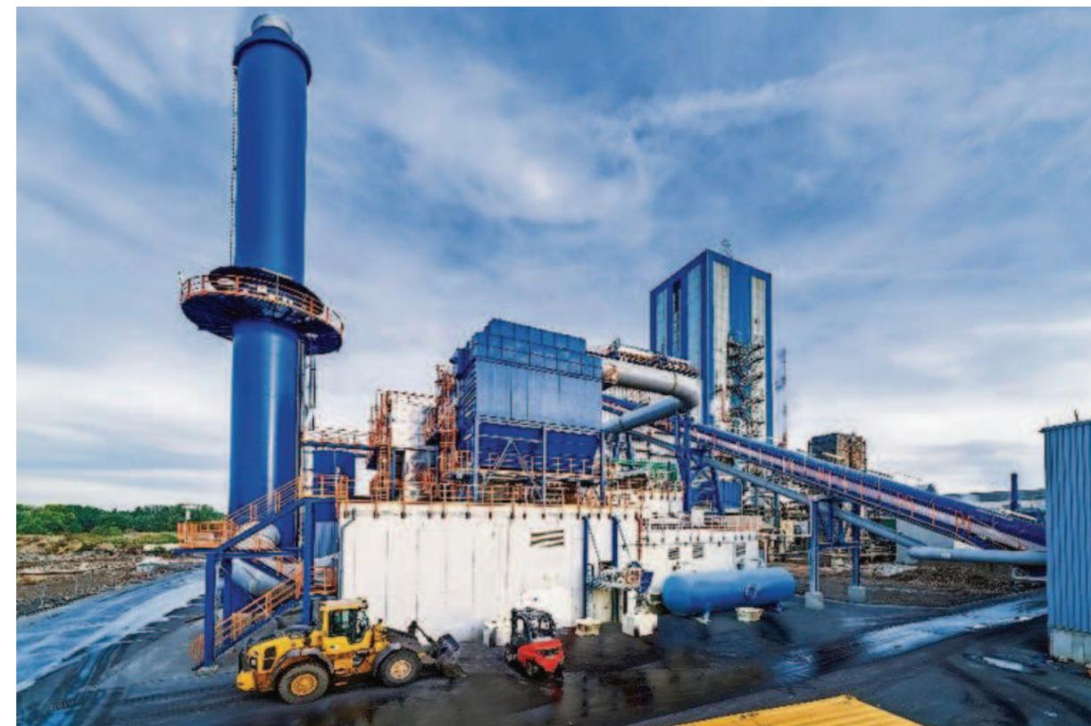
Die Bleihütte mit dem Reduktionsofen im Vordergrund und dem Badschmelzofen.
