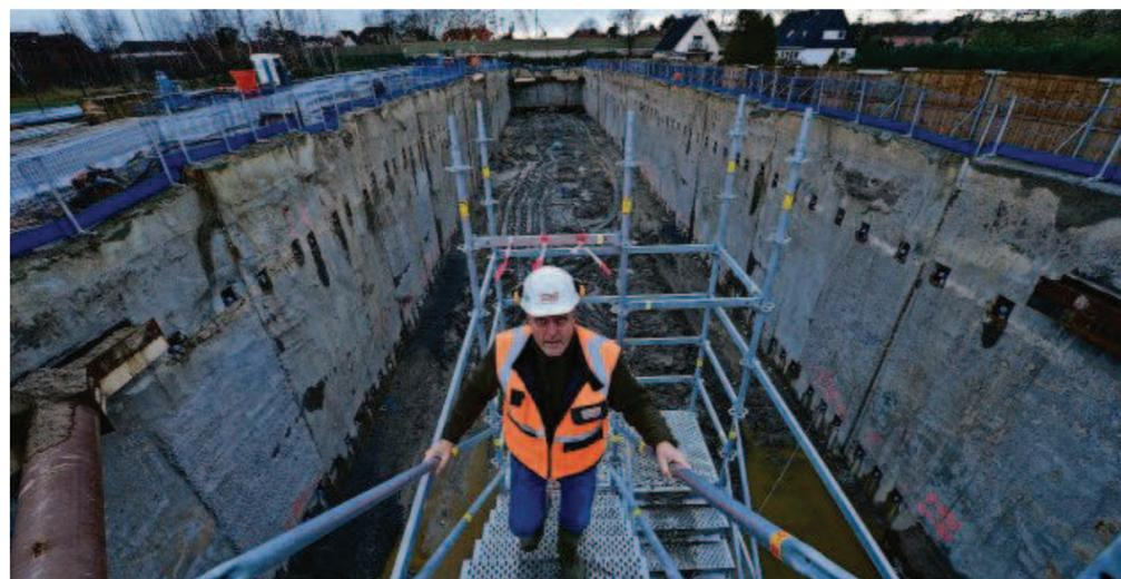
Die gesamte Tunnelstrecke wird in 23 Baudocks aufgeteilt, in denen die Tunnelsegmente entstehen.
