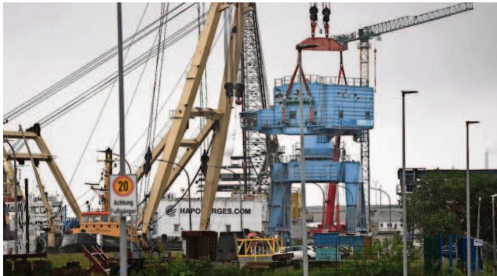
Mit zwei Schleppzügen traf auch der Schwimmkran „Enak“ in seinem früheren Heimathafen Bremerhaven ein, um Gitterausleger und das obere Maschinenhaus des 30 Jahre alten Krans auf der Lloyd-Werft aufzustellen.
