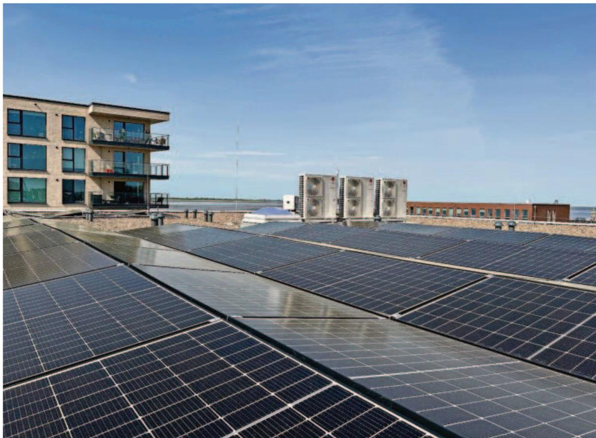
Das Gebäude „Panorama 2“ wurde von swb mit einer 195 Quadratmeter großen Photovoltaik-Anlage auf dem Dach ausgestattet. Die Anlage produziert den Strom für die Wärmepumpen und liefert Energie für das Mieterstromkonzept. Fotos: swb
