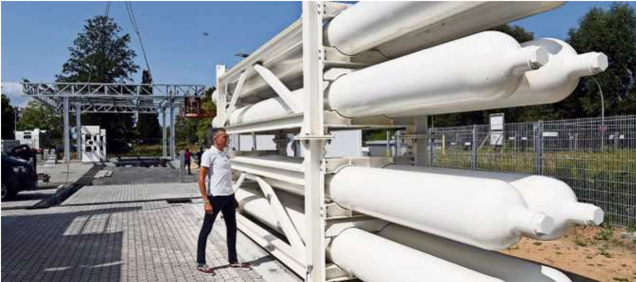
Am Standort „Zur Hexenbrücke“ in der Nähe von Bremerhaven Bus entsteht derzeit die Wasserstofftankstelle. Foto: Scheer
