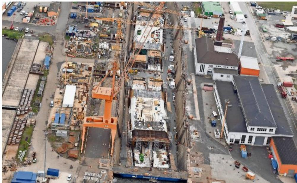
Der Bau der Tunnelröhren im Kaiserdock 2 der Lloyd Werft läuft dem Zeitplan etwas hinterher. Foto: Scheer
