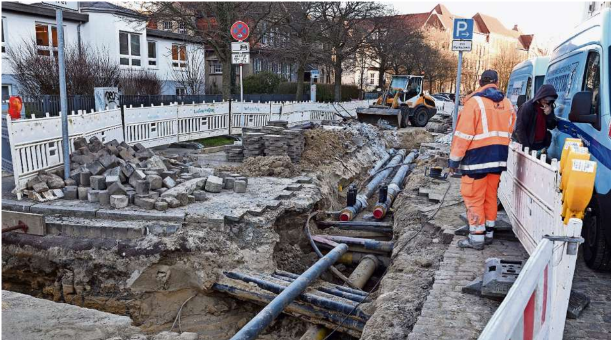
In Bremerhaven werden nach und nach neue Fernwärmeleitungen verlegt. Foto: Scheer
