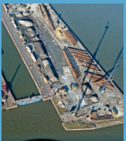
Bremenports lässt an der Columbuskaje einen Kabelkanal zum Anschluss von Kreuzfahrtschiffen an eine Landstromversorgung bauen.
