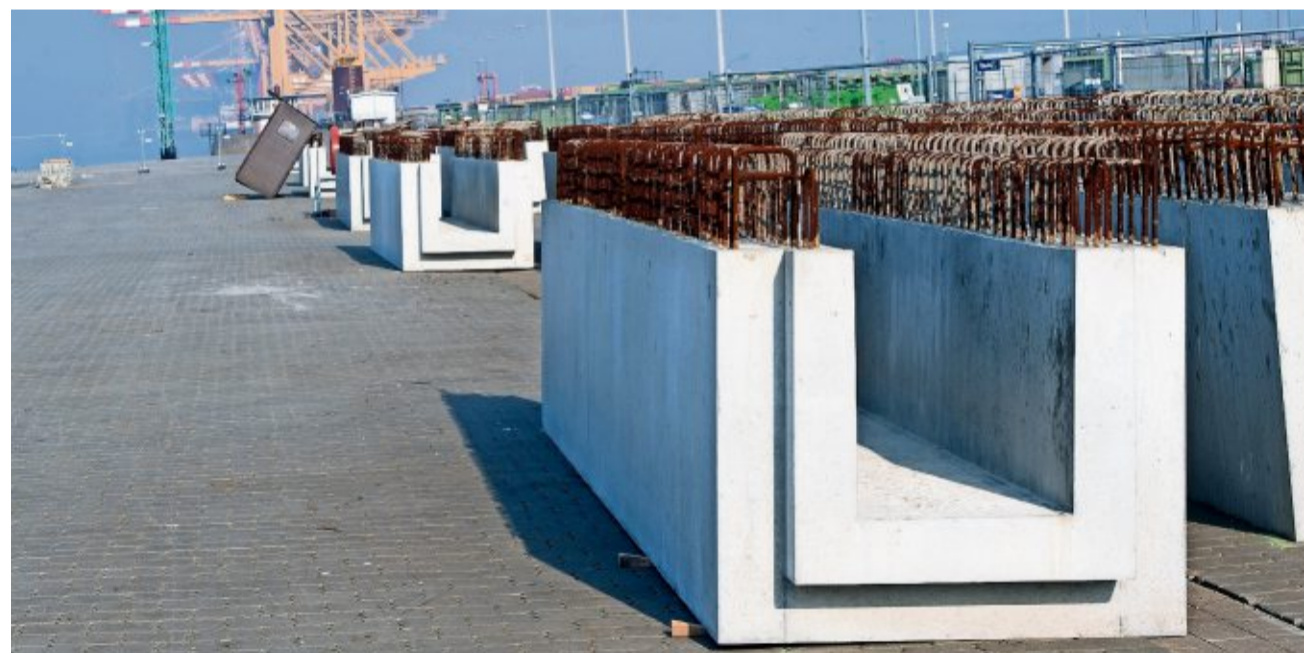
Der Kabelkanal für die neuen Landstromanschlüsse besteht aus 36 massiven Betonhalbfertigteilen.
