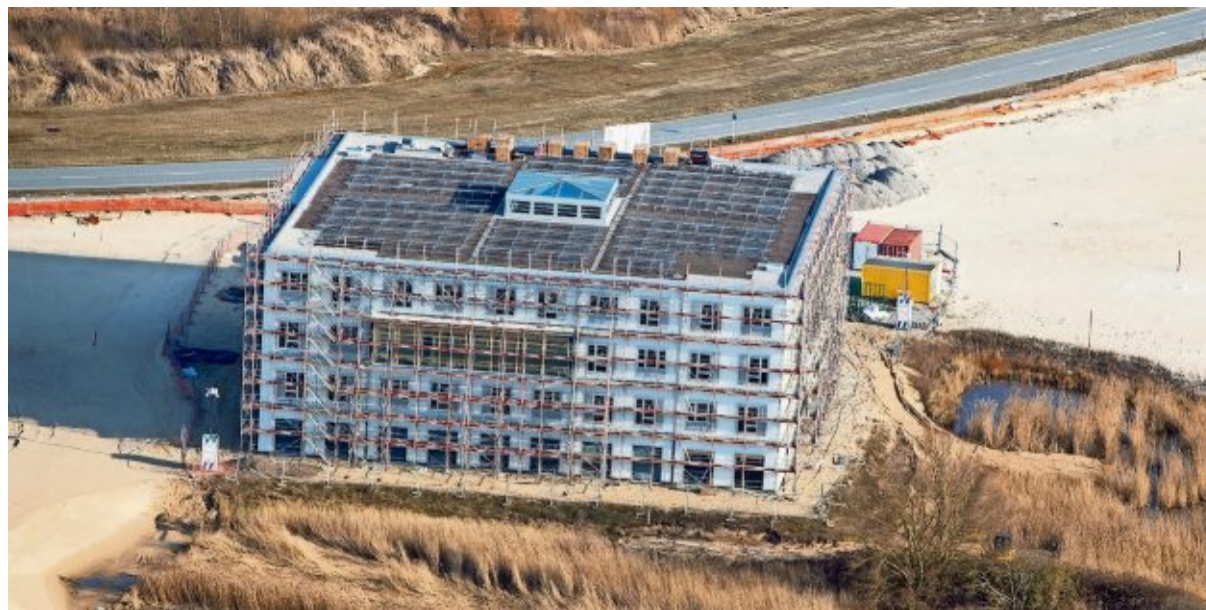
Neubau im Gewerbegebiet Lunedelta: Die Fassade des Gründungs- und Innovationszentrums ist fertiggestellt.
