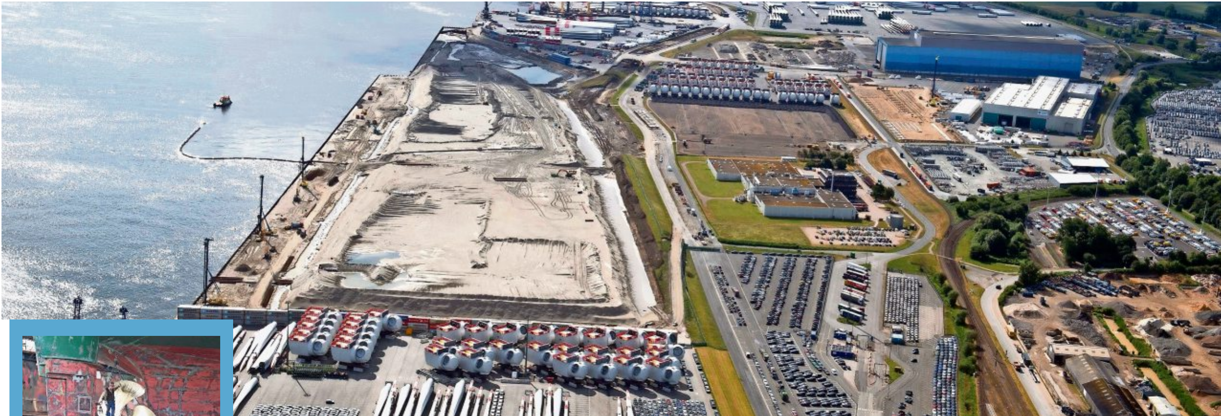
Sandaufspülung an den künftigen Liegeplätzen in Cuxhaven: 3,1 Millionen Kubikmeter Sand werden in das Baufeld eingespült.
