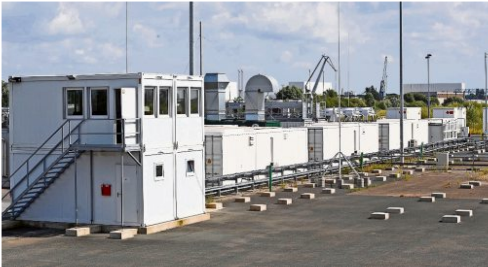
Einer der Partner des Projekts „H2B:Impact“ ist das Fraunhofer-Institut für Windenergiesysteme IWES, das in Bremerhaven-Luneort das Hydrogen Lab betreibt. Foto: Scheer
