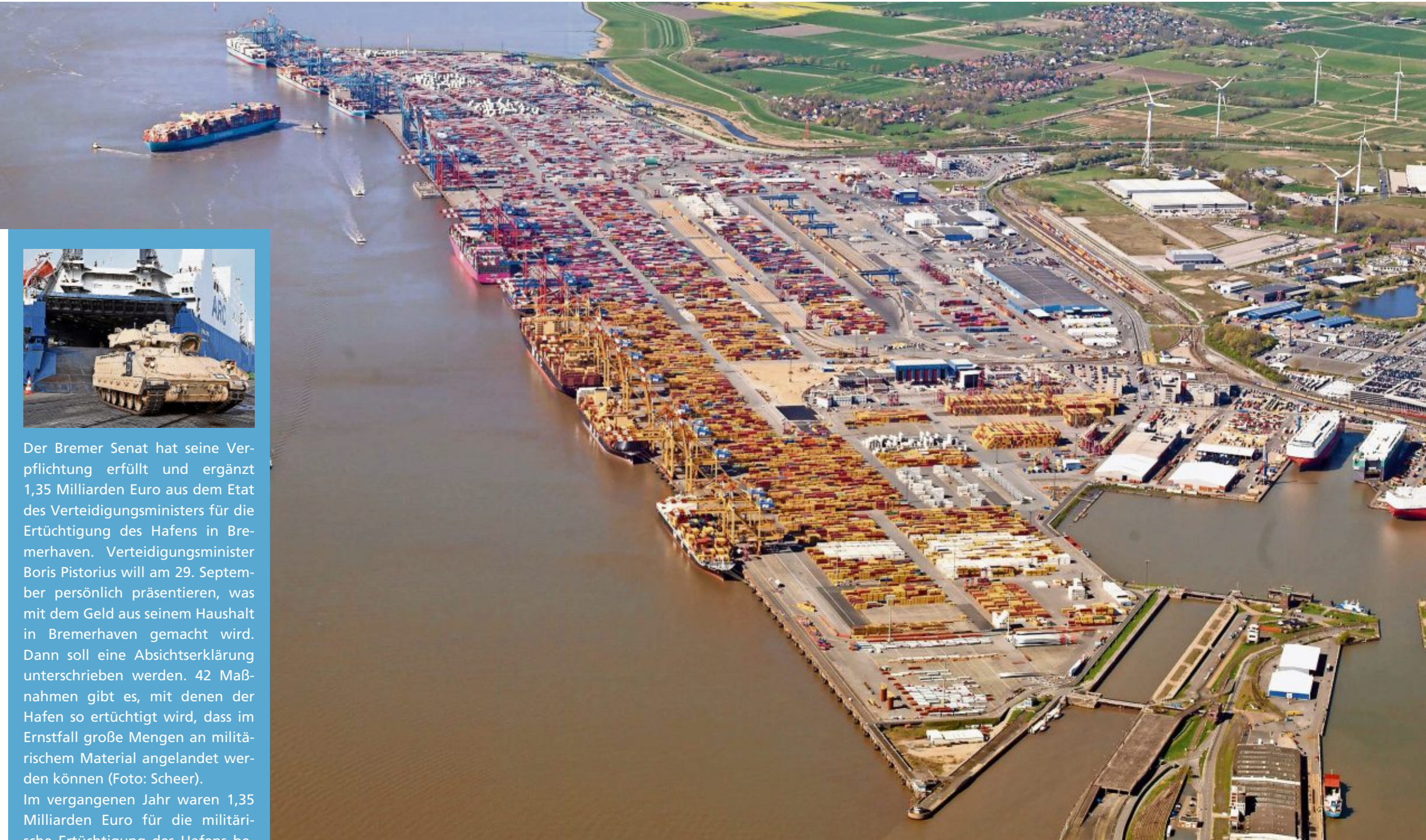
Die Mittel des Verteidigungsministeriums, die zur Ertüchtigung des Bremerhavener Hafens für den Umschlag militärischen Materials vorgesehen sind, werden unter anderem in die Modernisierung des Containerterminals 1 am Süden der Bremerhavener Stromkaje fließen. Foto: Scheer
