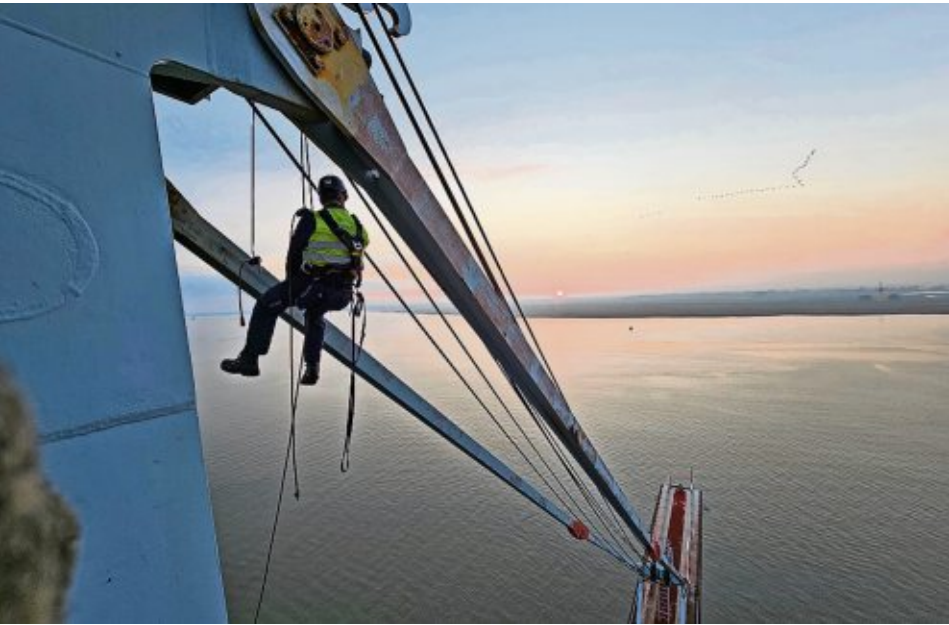
Das ist Thomas Ulrich bei der Kontrolle von Gelenkverbindungen an einem Kran beim Unternehmen Glencore. Foto: Spezial Montage Service
